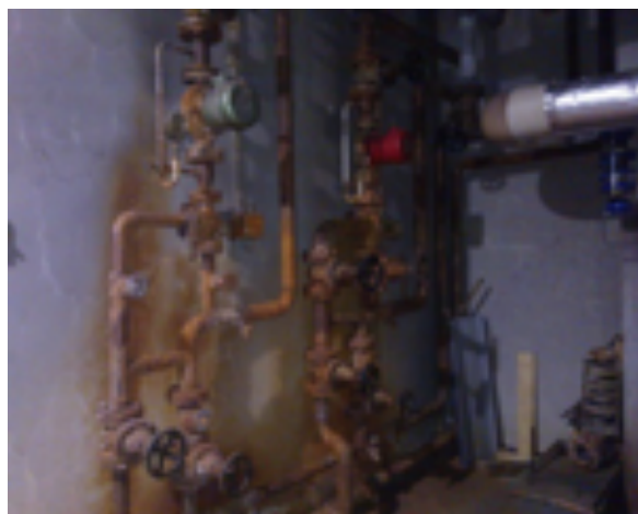
Kuva 1 Lämmönjakuhuoneen eristämättömät venttiilit ja eristetyt putket
