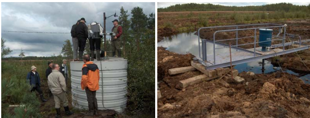
Kuva 3. Turveruukki Oy:n Järvineva on uusi tuotantoalue, jossa on käynnissä ympärivuotinen päästötarkkailu. Kesällä vedet pumpataan pintavalutuskentälle.
