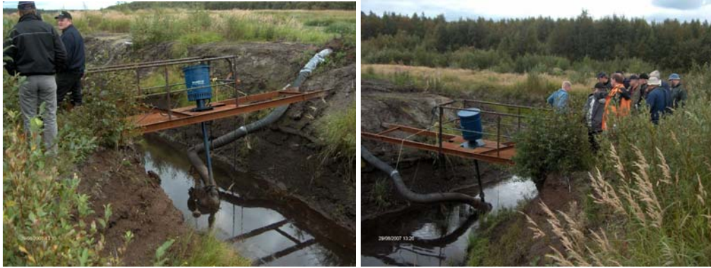
Kuva 2. Turveruukki Oy:n Hangasnevilla vettä nostetaan sähkökäyttöisellä pumpulla penkan yli haihdutus-imeytyskentälle.
