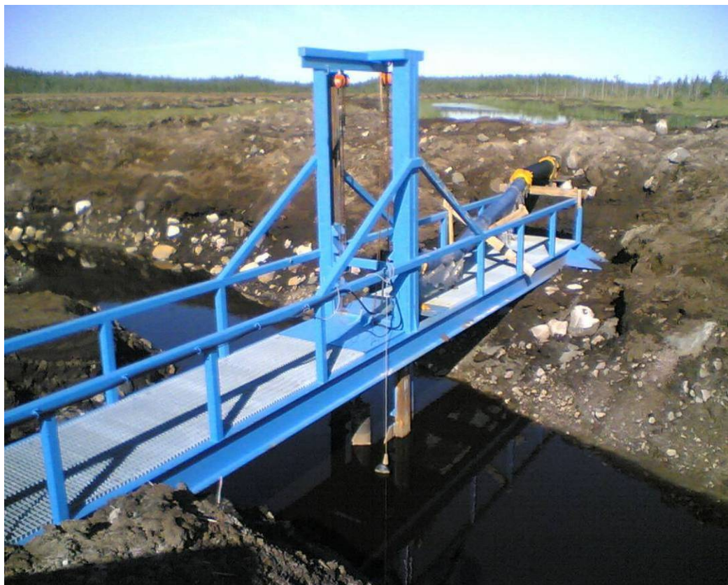
Kuva 17. Turveruukki Oy:n käyttämä pumppausilta ja uppopumppu.
