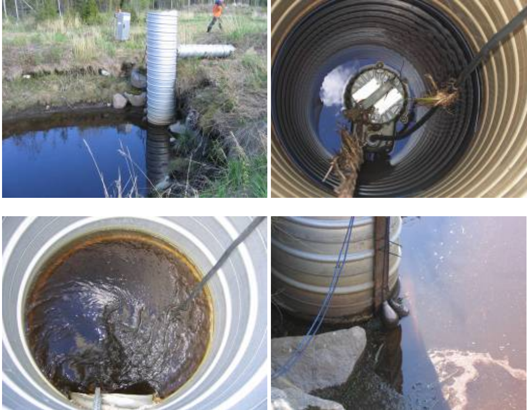
Kuva 13. Nostokuilupumpun asennuskaivo asennettuna pumppausaltaan pohjalla olevaan betoniseen ontelolaattaan (ylh. vas.), nostokuilupumppu asennettuna kaivon välikannelle (ylh. oik.), pumppu nostanut kaivon (nostokuilun) täyteen vettä, joka virtaa alareunassa näkyvästä vedenjohtoputkesta (vas.), pintaviipat ohjaavat pumpun käynnistystä ja sammutusta (oik.). Pumppu Flygt:in keskipakopumppu.
