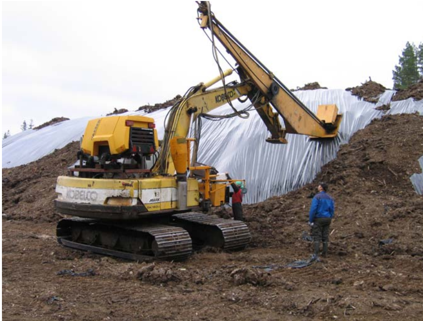
Kuva 10. Aumojen kairausta paineilmakairalla.
