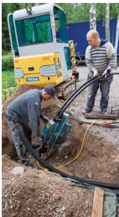
Lämmönkeruuputkisto asennetaan porakaivoon ja täytetään jäätyttömällä keruuliuksella.
