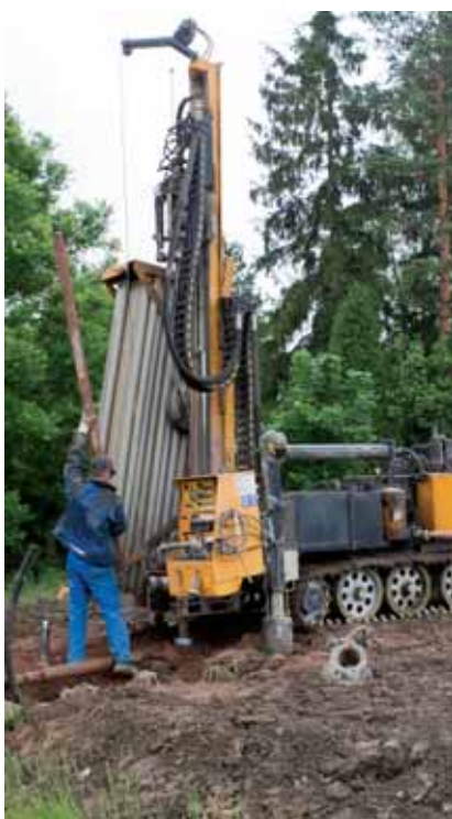
Porakaivo on yleisin maalämpöpumpun lämmönlähde.
