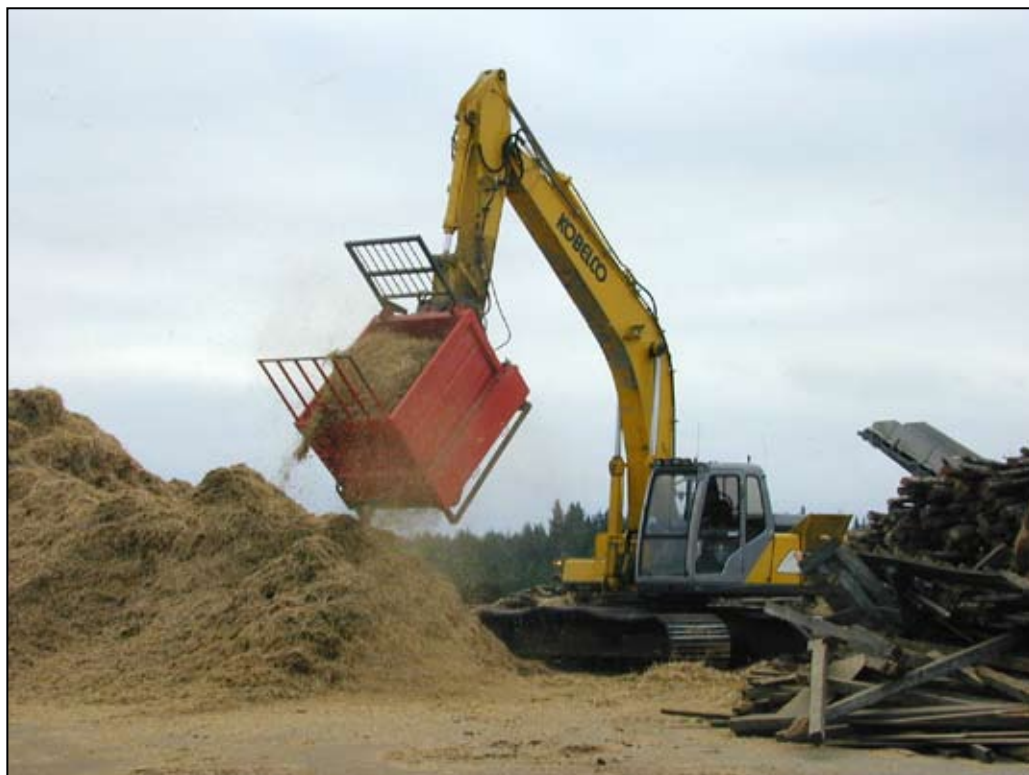
Ruukohelpipaalien murskausta kaivinkonemurskaimella. (Kuva: Timo Löijönen)
