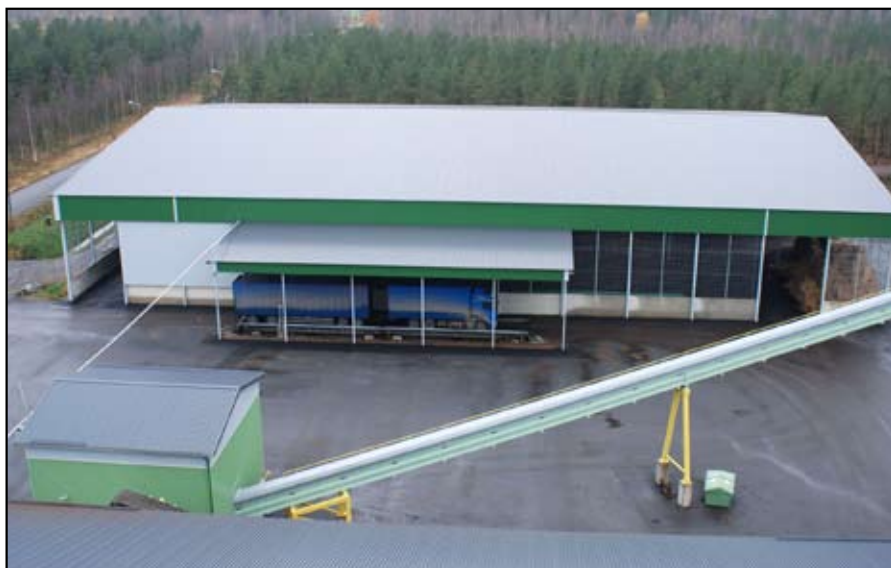
Kokkolan Voima Oy on investoinut ruukohelpipaalien varastointihalliin, jossa on paalinpurkulinja ja pneumalaitteisto helpisilpun puhaltamiseksi vasemmalla kulkevaa putkea pitkin suoraan kattilaan. (Kokkolan Voima Oy)
