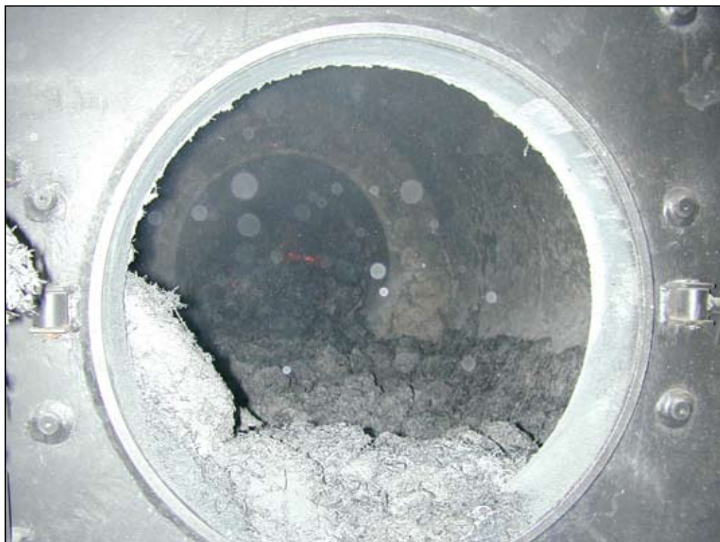
Olki- ja ruokohelpituhka ovat tilaavieviä, vaikka palaminen tapahtuisikin täydellisesti. (Timo Lötjönen, MTT)
