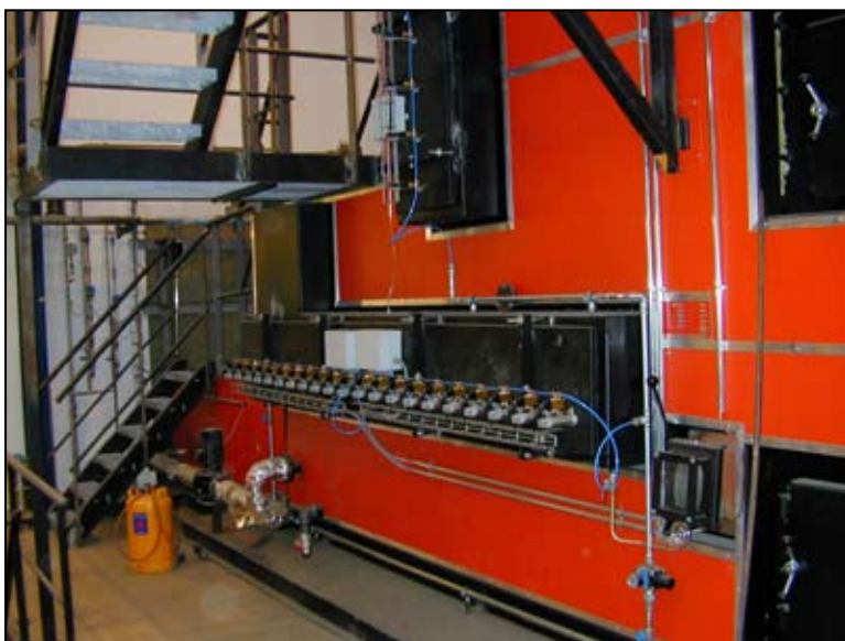
Tanskalaisvalmisteinen oljen ja ruukohelven polttoon sopiva 6,3 MW:n tehoinen arinakattila. (Timo Löytönen, MTT)
