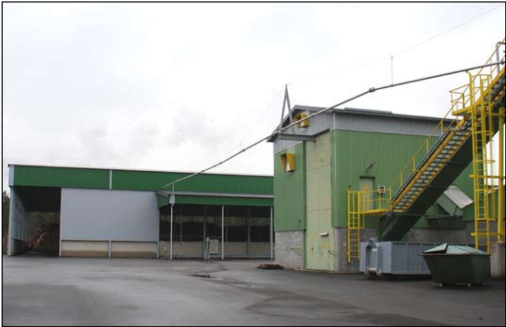
Kokkolan Voima Oy:n pneumaattinen syöttölinja, joka vie ruokohelpisilpun paalivarastolta suoraan leijupetikattilan kylkeen. (Kokkolan Voima Oy)
