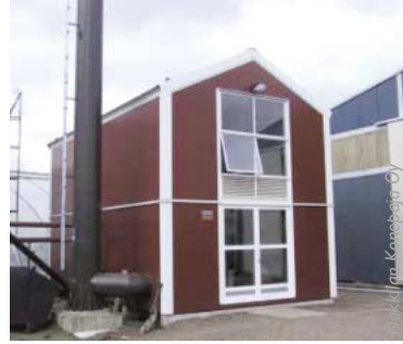
Tervossa sijaitsevan Tarvaisen Puutarhan vuonna 2001 valmistunut 1,0 MW lämpölaite käyttää polttoaineena haketta, kuorta, purua ja palaturvetta.
