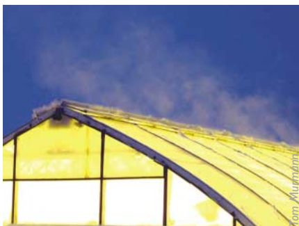
Rakenteiden lämpöhäviöt kasvattavat lämmitykseen käytettävien polttoaineiden kulutusta.
