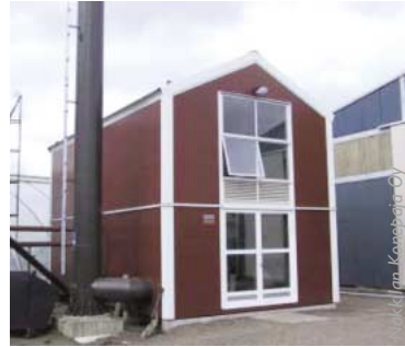
Tervossa sijaitsevan Tarvaisen Puutarhan vuonna 2001 valmistunut 1,0 MW lämpölaitos käyttää polttoaineena haketta, kuorta, purua ja palaturvetta.
