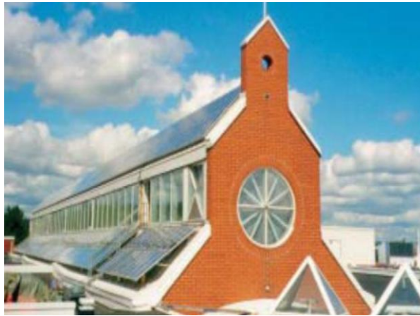
Kuva 4.24. Lielahden Citymarketin katolla oleva 39 kW järjestelmä [71].
