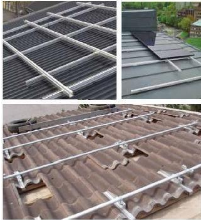
Kuva 4.3. Aurinkopaneelien kattoasennustelineet erilaisiin kattomateriaaleihin kiinnitettynä [37] [45].
