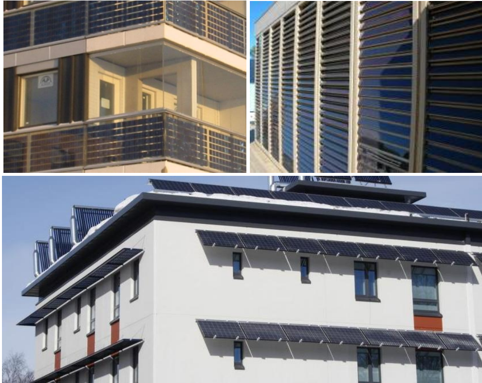
Kuva 4.7. Eko-Viikissä parvekekaiteisiin, Saksassa sälekaihtimiin ja Kuopiossa ikkunan varjostimiin integroituja aurinkokennoja [49][50][51].
