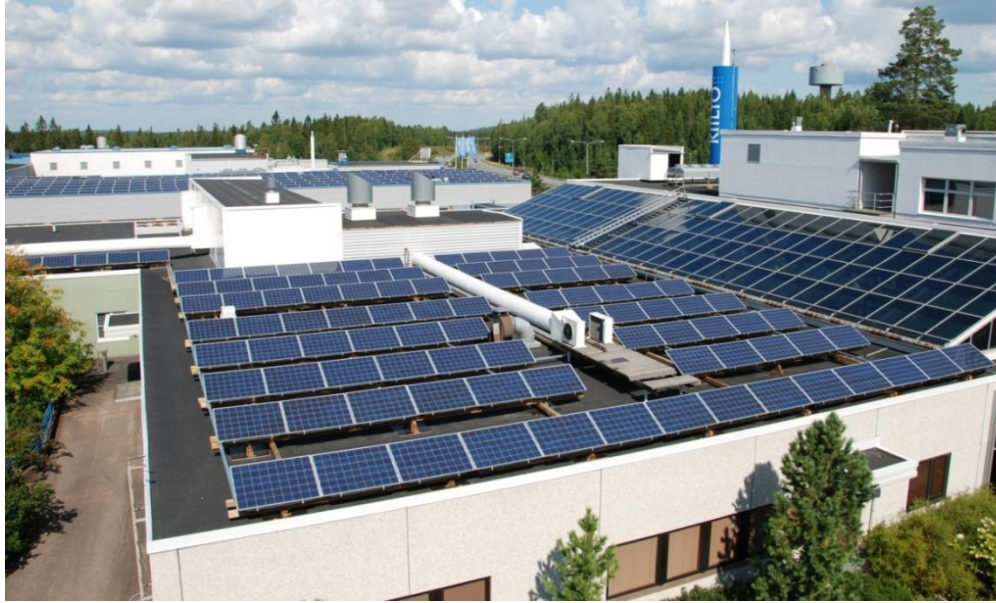
Kuva 4.4. Kiilto Oy:n tehtaan katoilla oleva aurinkosähköjärjestelmä [46].
