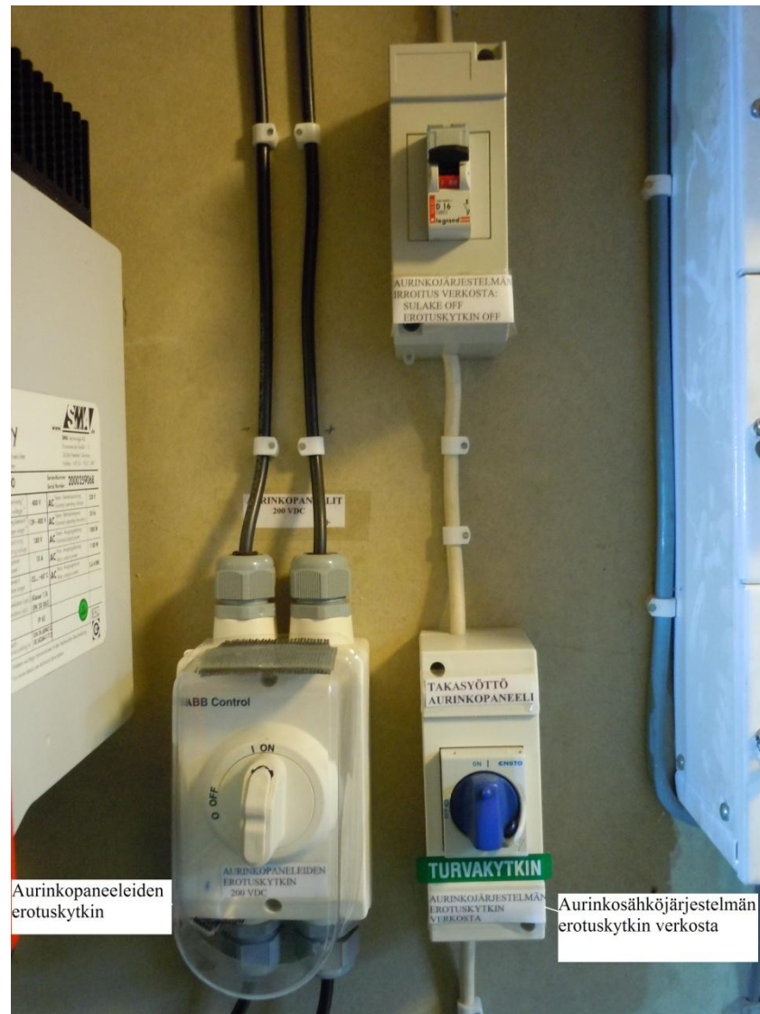
Kuva 4.17. Erään 1,3 kW järjestelmän erottimet.
