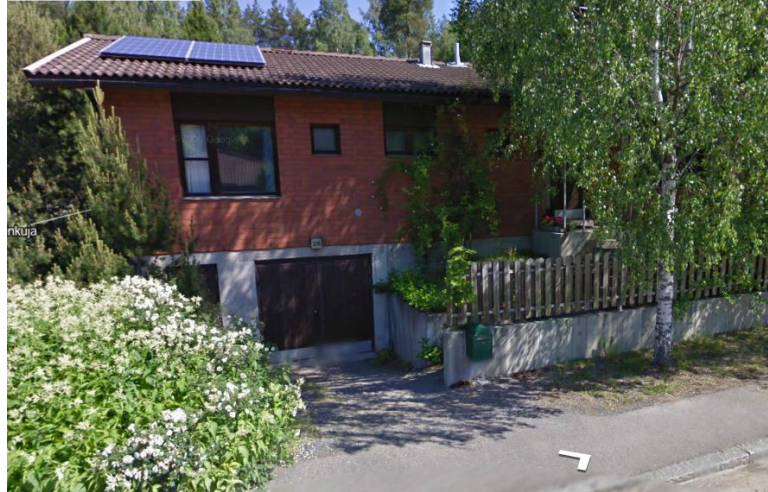
Kuva 4.23. Hervannassa omakotitalon katolle asennetut aurinkopaneelit [70].
