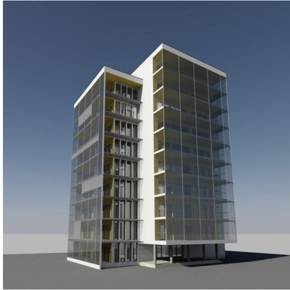
Kuva 9. SunZEB-pistetalo. Lasitetut parvekkeet ja varjostava säleikkö ikkunoiden yläpuolella estävät sisätilojen liiallisen yllämpenemisen.
