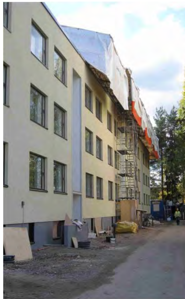
Korjauksen jälkeen. Kuvat:VAV Asunnot Oy,Teija Ojankoski
