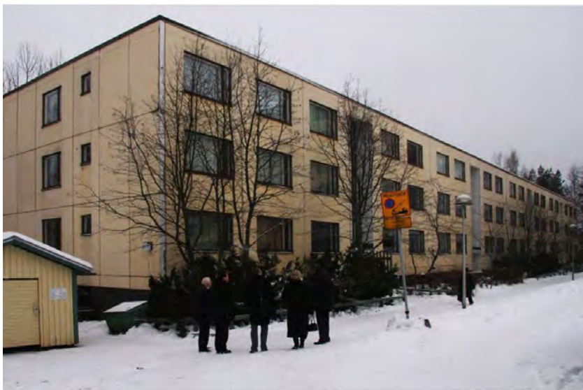
Sahatie 2 ennen korjausta.. Kuva:VTT, Pekka Huovila
