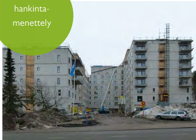
Palvelutalo rakentuu, tilanne alkukeväästä 2013.
