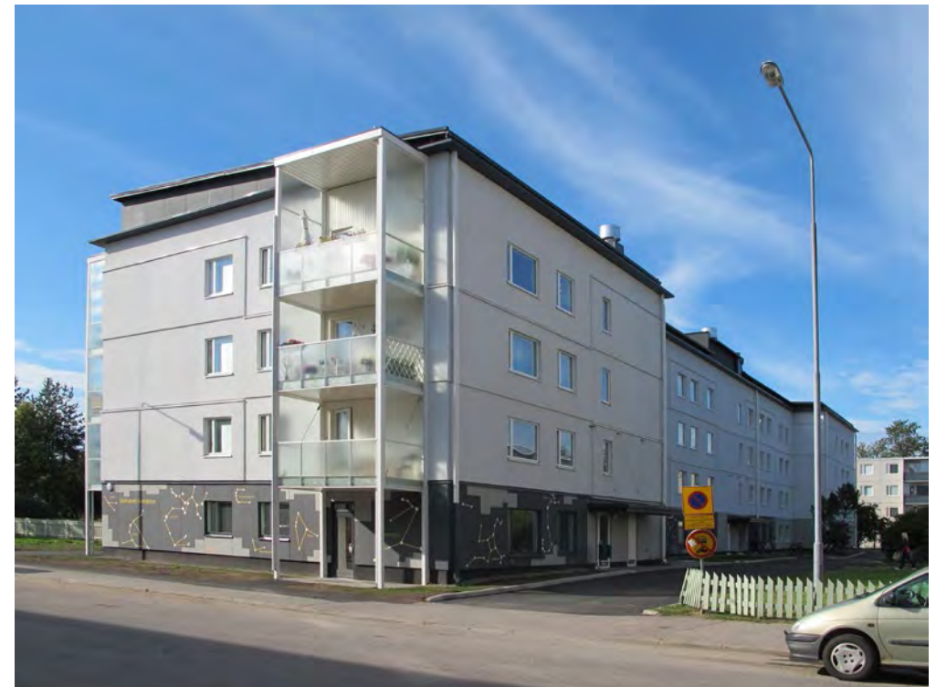
Korjauksen jälkeen. Kuvat: Kimmo Lylykangas.
