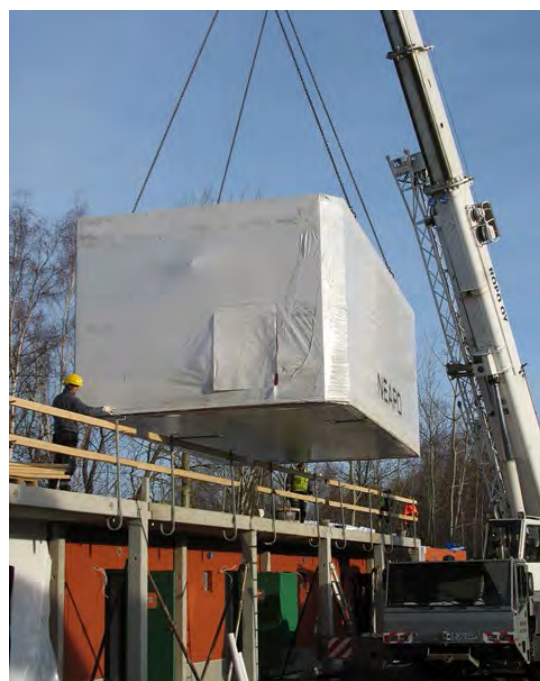
Osmankäämintien työmaa. Kuva: VAV Asunnot Oy, Teija Ojankoski
