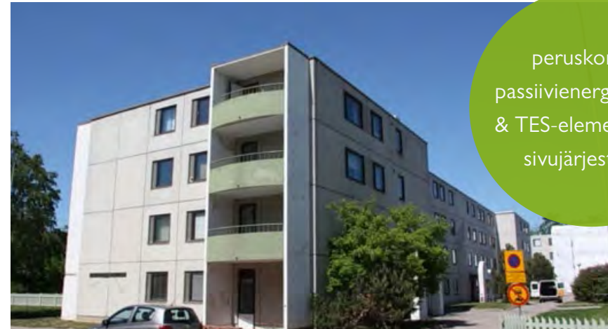
Saturnuksenkuja 2 ennen korjausta.
