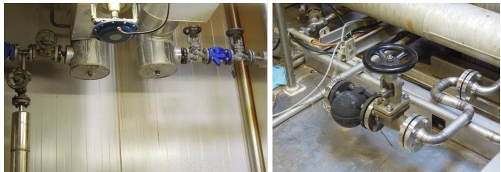
Kuva 11. Vasemmalla kahden eripaineisen höyryverkoston putkistoa, oikealla uimurilauhteenerotin.
