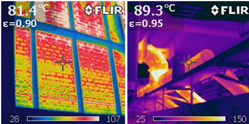
Kuva 25. Lämpökameran hyödyntäminen rakenteiden tarkasteluissa
