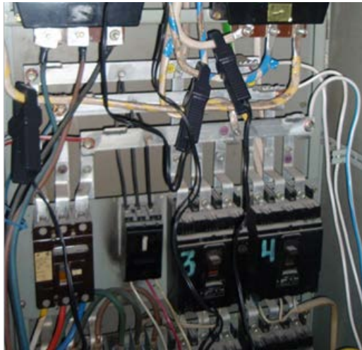
Kuva 21. Esimerkki virtamittauspihtien kytkennästä
