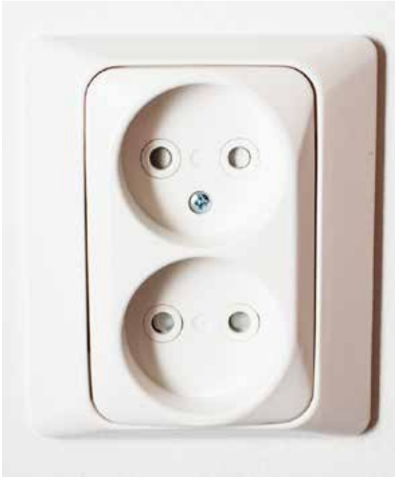
0-luokan maadoittamaton pistorasia.
