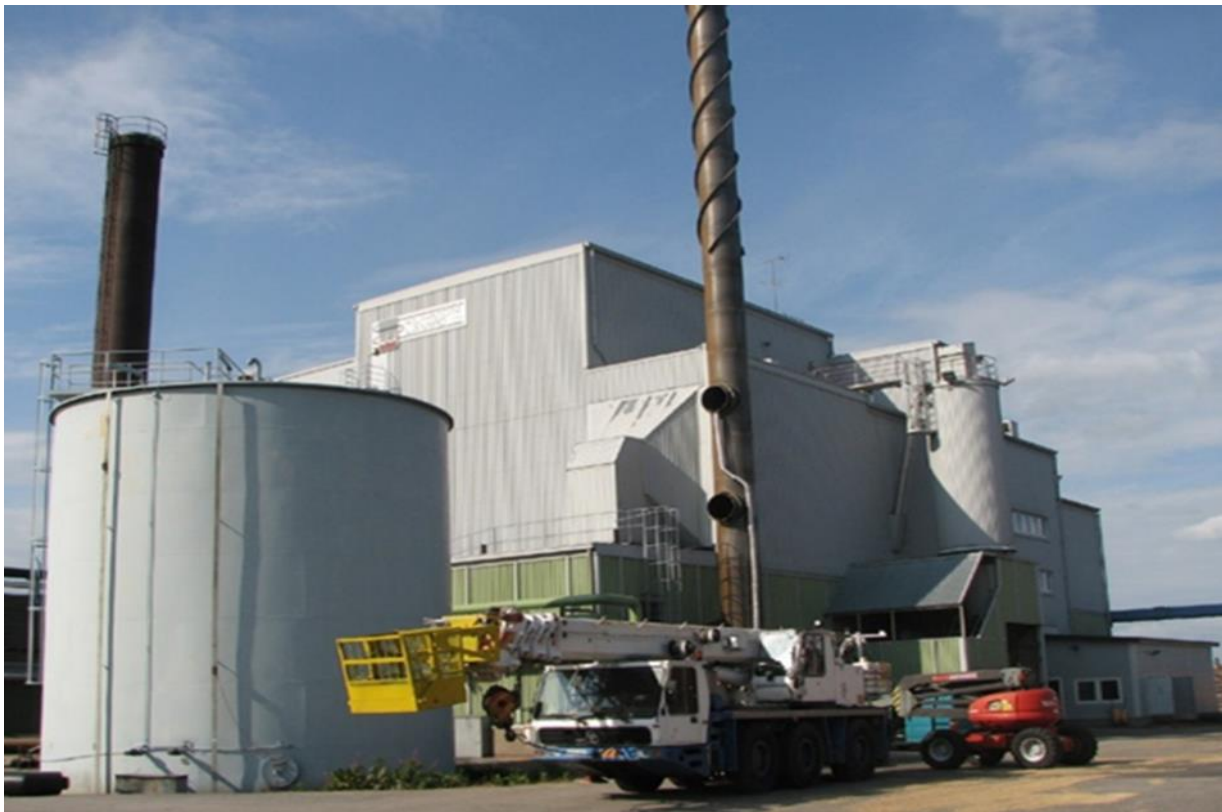
Kuva 3. Kuhmon Lämpö Oy, johon parasta aikaa tehdään savukaasujen lämmöntalteenottojärjestelmää. Talteen otetulla lämmöllä kuivataan tehtaiden sivuvirtoja.
