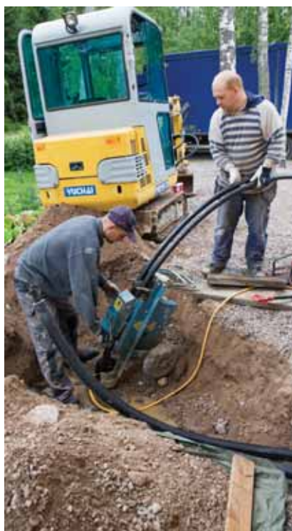
Kollektorn läggs ner i borrhålet och fylls med en frostfri vätska.
