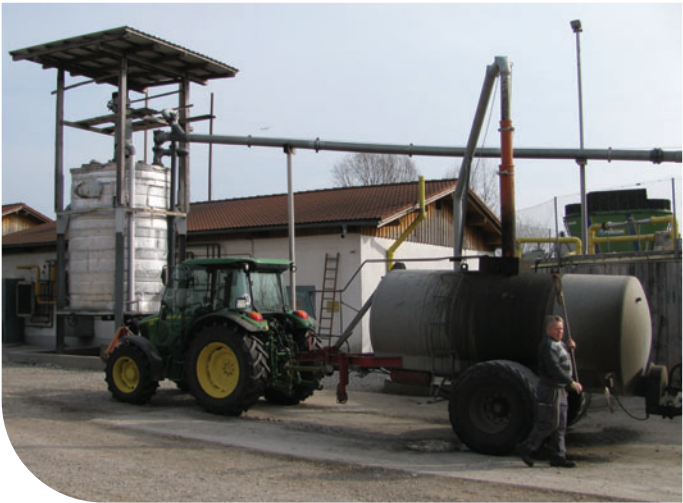
Bild 9. På den här tyska anläggningen rötar man gödsel, ensilage och matrester. Matresterna genomgår värmebehandling (70 °C 1 h) i behållaren till vänster innan de matas in i biogasanläggningen. Gödsel och ensilage matas in som sådant.
