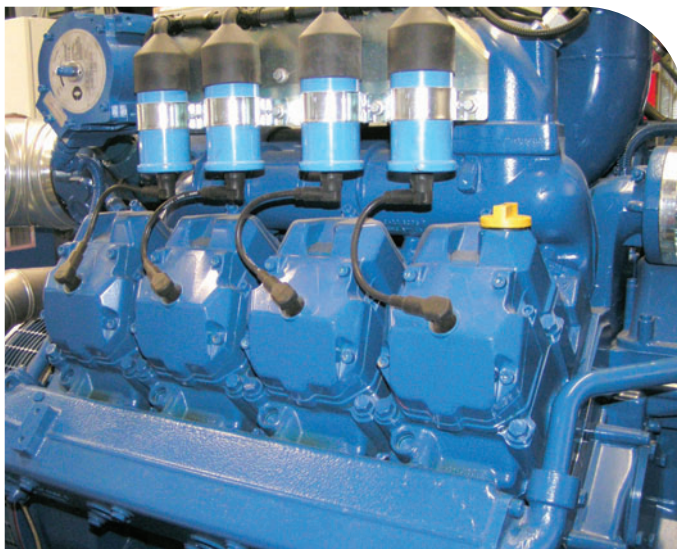
Bild 18. Större biogasanläggningar använder oftast stora ottomotorer vid generering av elektricitet.
