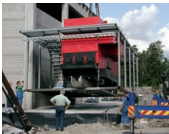
Tuusulan Energian kattila asennettiin kesällä 2003.
