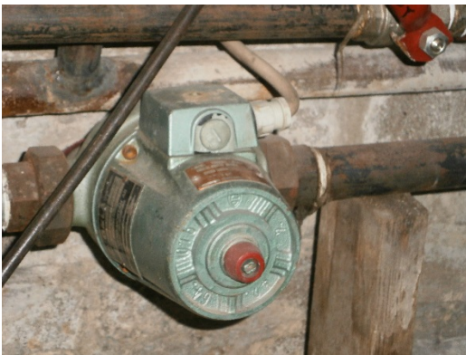
Kuva 3e Yli 40-vuotias kiertovesipumppu
