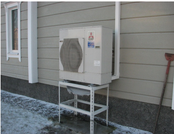
Kuva 5a Ilma-vesilämpöpumpun ulkoyksikkö
