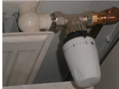
Kuva 3d Uusittu patteri ja patteriventtiili
