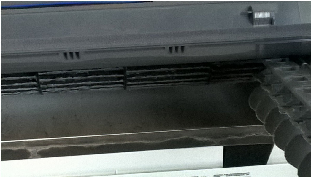
Kuva 4b 5 vuoden aikana sisäyksikön puhaltimeen kertynyt pöly, jota ei saa pois kotikonsteilla
