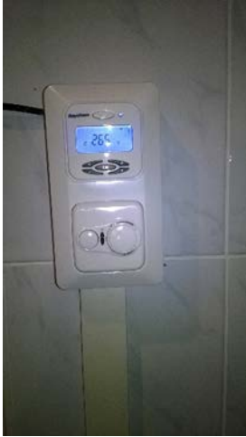
Kuva 3a Kuvassa ylempänä ajastettava älytermostaatti, jossa on monipuoliset säätöominaisuudet. Alempana analoginen lattialämmitystermostaatti.
