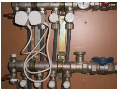
Kuva 3g Lattialämmityksen toimilaitteita jakotukilla
