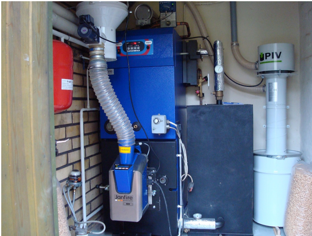
Kuva 7k Pellettikattila omakotitalossa
