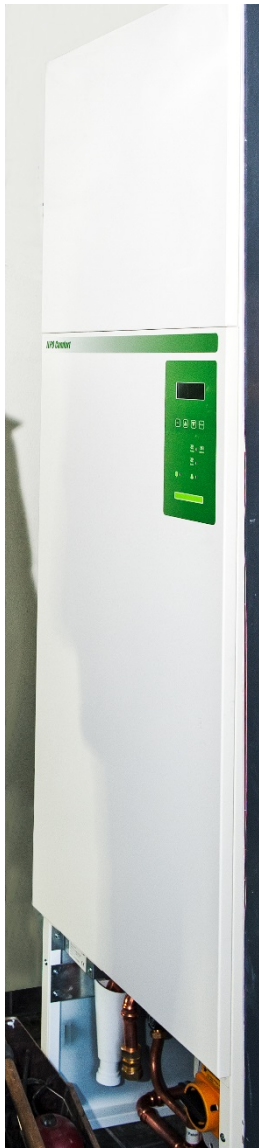
Kuva 2c Poistoilmalämpöpumppu, teholuokka noin 5kw
