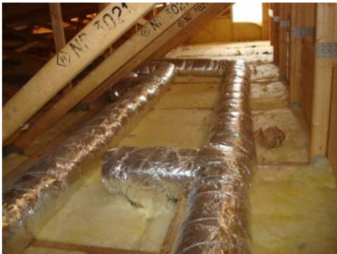
Kuva 9f Eristettyjä ilmanvaihtokanavia yläpohjassa (kuva BuildUpSkills)
