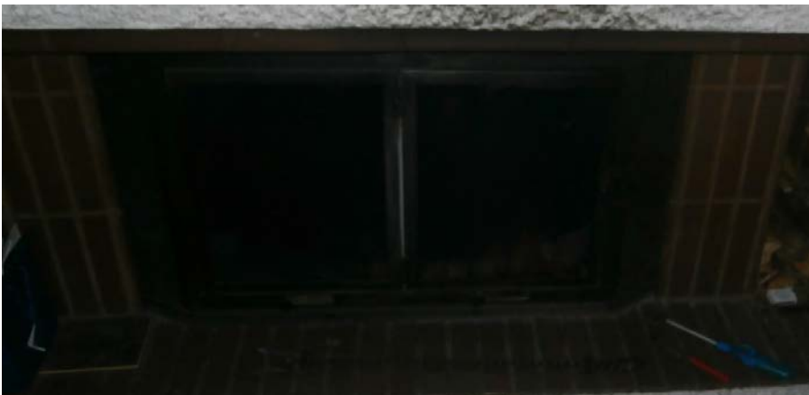
Kuva 2y Takkasydän jälkiasennettuna vanhaan avotakkaan
