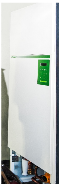
Kuva 2c Poistoilmalämpöpumppu
