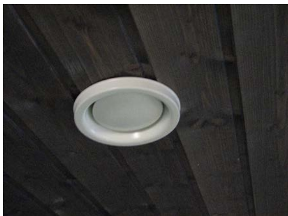
Kuva 9b Poistoilmaventtiili
