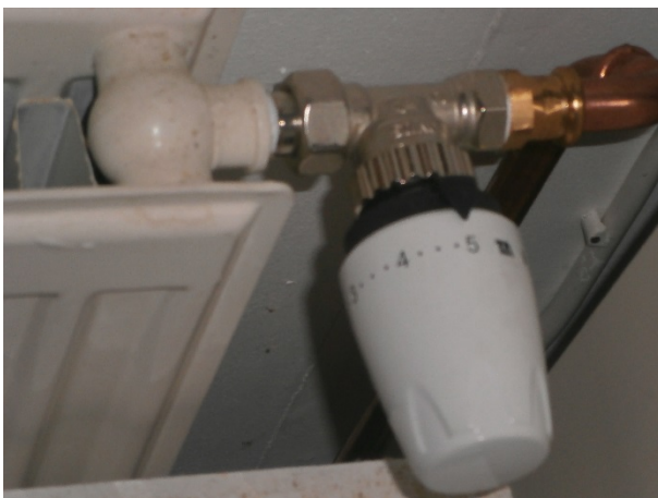
Kuva 3d Uusittu patteri ja patteriventtiili
