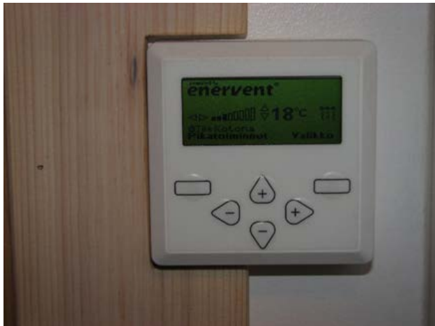
Kuva 9a Ilmanvaihtokoneen säädin
