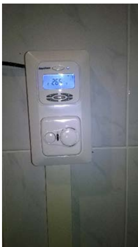
Kuva 3a Ylhäällä ajastettava älytermostaatti, jossa on monipuoliset säätöominaisuudet. Alhaalla tavanomainen lattialämmitystermostaatti
