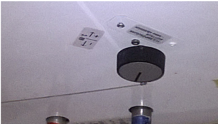
Kuva 2d Varaajan lämpötilansäätö (termostaatin säätö)
