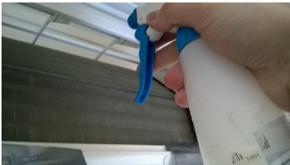
Kuva 4d Sisäyksikön ilmansuodattimien ylläoleva lämmönsiirtolamelli voidaan myös pestä tarkoitukseensuunnittelulla pesuaineella (ns. kennon pesuaine). Pesuaineen jälkeen on tehtävä perusteellinen huuhtelu vedellä, katso tarkemmin pesuaineen ohjeesta. Pesuainetta myyvät ilmalämpöpumppujen huoltoliikkeet.
