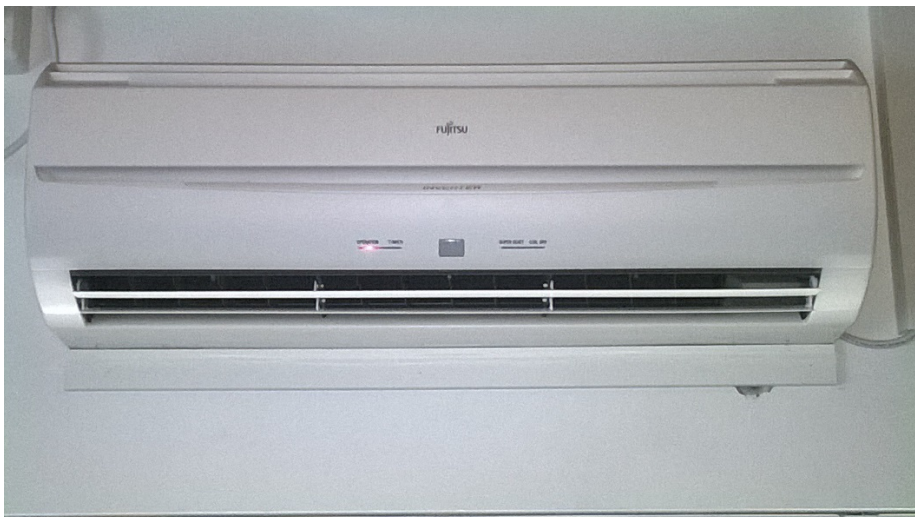
Kuva 4a Ilmalämpöpumpun sisäyksikkö
