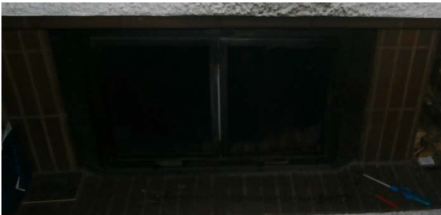
Kuva 2y Takkasydän jälkiasennettu vanhaan avotakkaan
