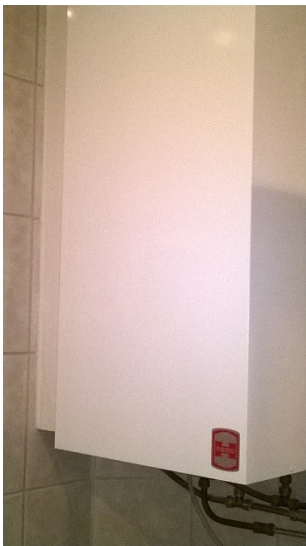
Kuva 2e 60-litrainen käyttövesivaraaja
