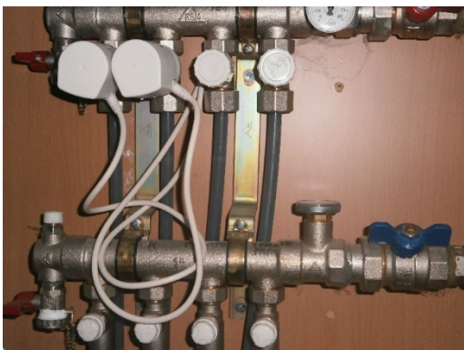
Kuva 3g Lattialämmityksen toimilaite
