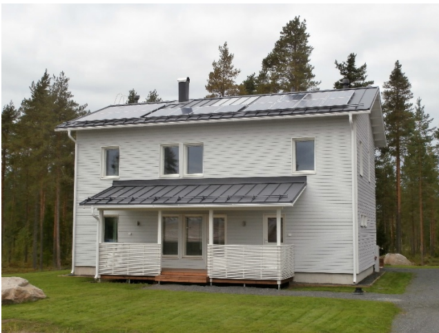
Kuva 2k Aurinkopaneelit talon katolla
